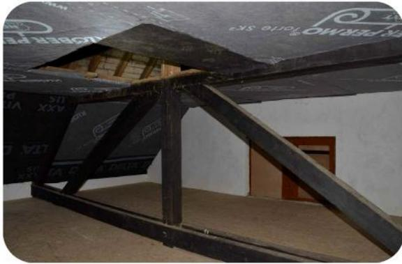
**Le comble tamponé avec accès à la hot-box au-dessus. Dans le fond, une ouverture pré-existante a été transformée en chiroptière avec chicane.**
